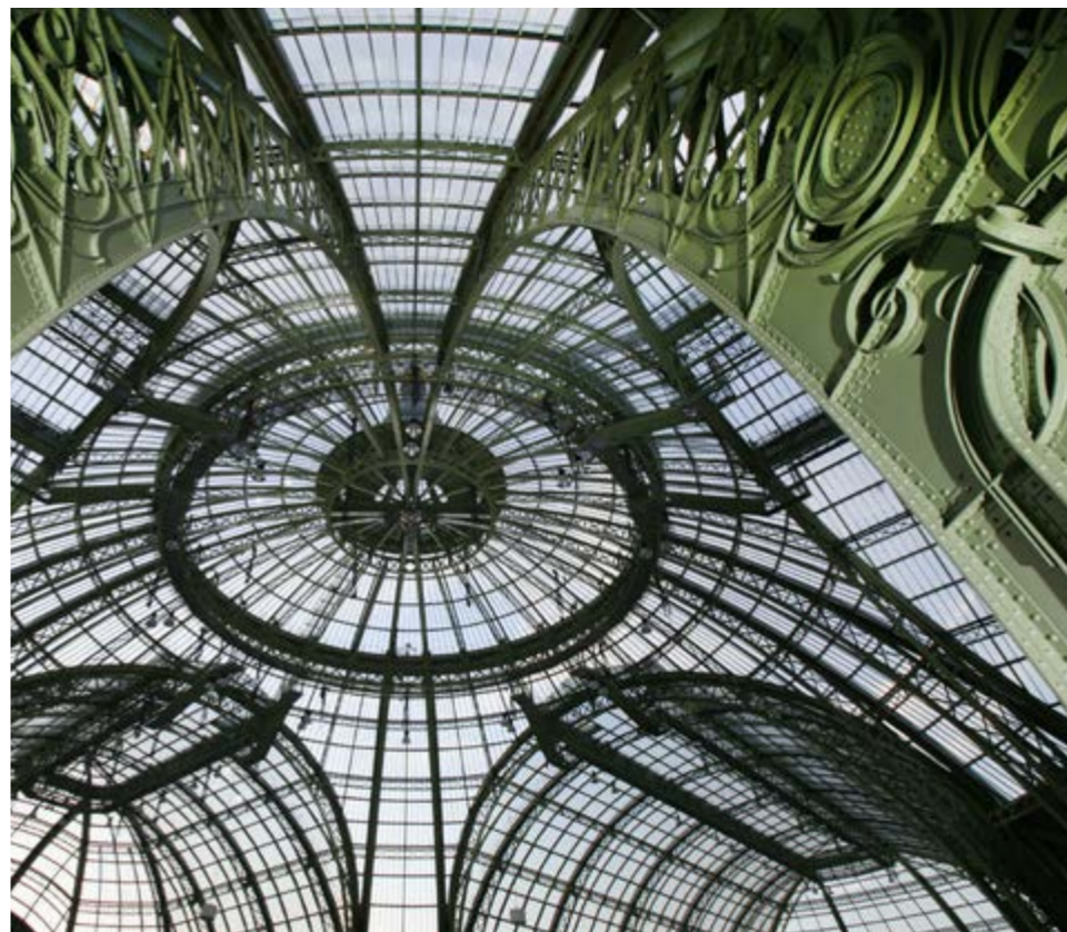
Ref.12-571624. «La verrière et la structure métallique de la Nef du Grand Palais» - Photographie Gaillarde Raphaël www.barrisol.com
